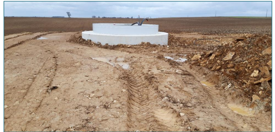
De gauche à droite, la fondation coulée puis recouverte de terre végétale. Seul le fût (embase du mât, environ 5,5 m) reste visible pour l'accueil de la tour
