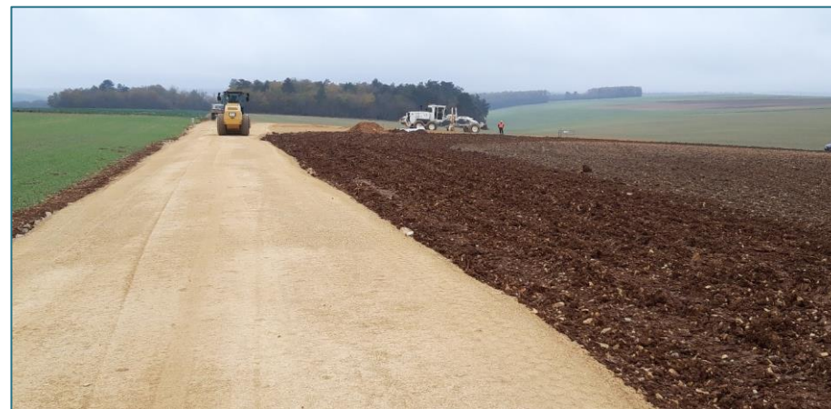
Revêtement de piste, parc éolien de Sarry, travaux 2020
