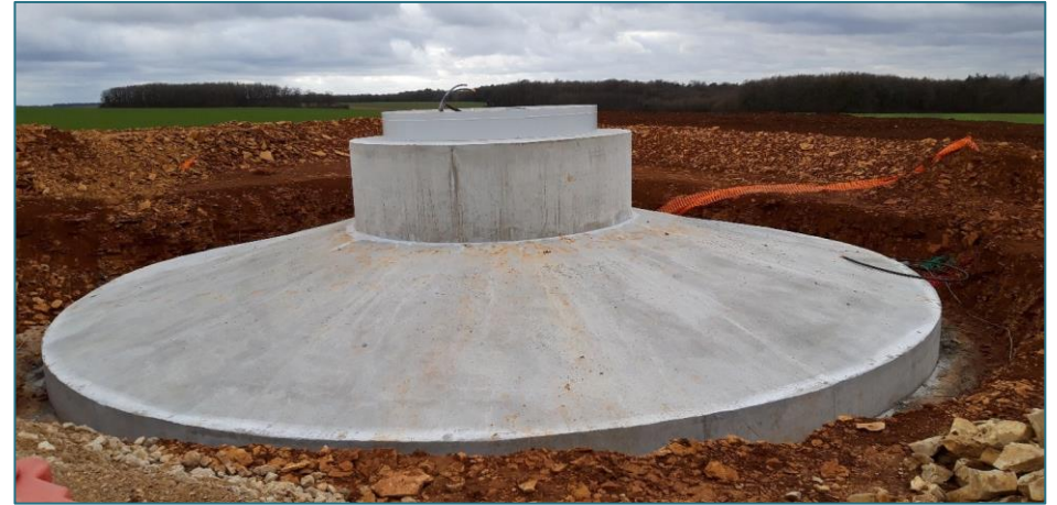
Coulage du béton de la fondation – environ 305 à 325 m 3
