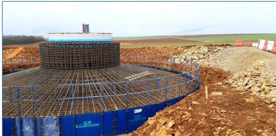
Ferraillage de la fondation
