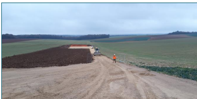
Revêtement de piste et plateforme, parc éolien de Sarry, travaux 2020
