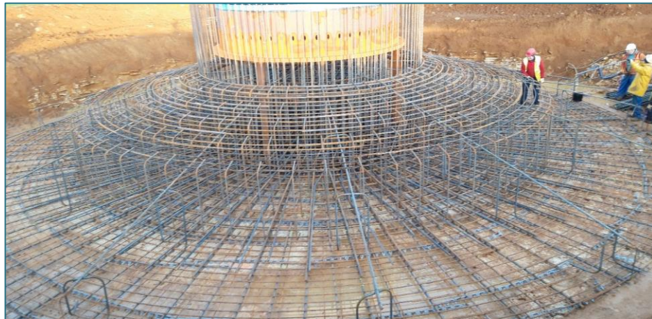
Ferraillage de la fondation
