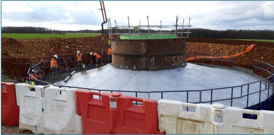
Coulage du béton de la fondation – environ 305 à 325 m 3
