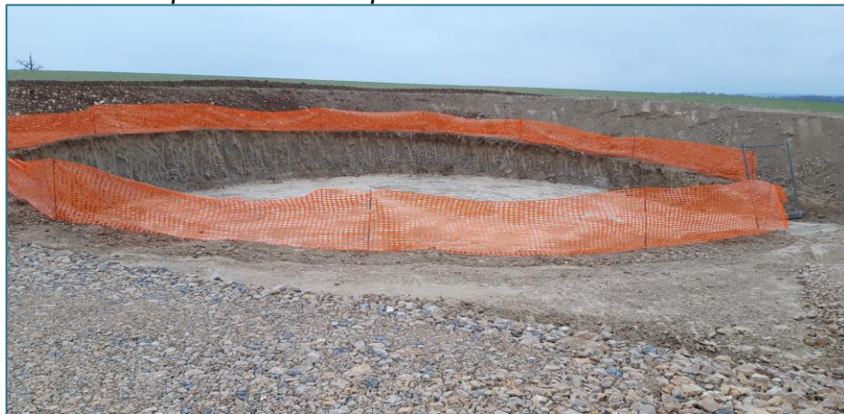
Préparation de la fondation – creusage du trou et assise – 19,5 m de diamètre
